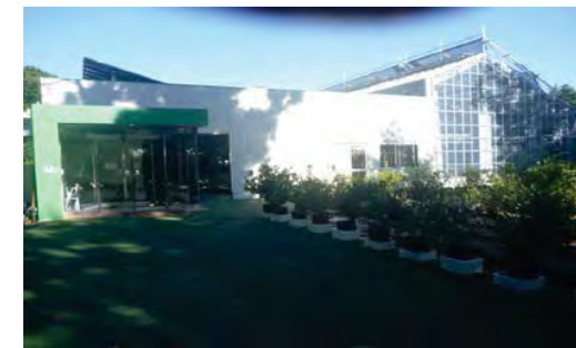
太陽光発電設備を備えた植物工場
